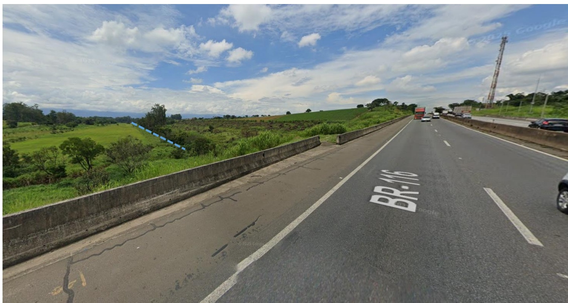
Figura 2-13 Cruzamento entre Ribeirão do Curtume (em azul tracejado) e a Rod. Pres. Dutra – lado norte
